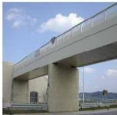
Slika 15. Pješački most u Okinawi (Japan) napravljen od hibridnog kompozitnog materijala [16]
