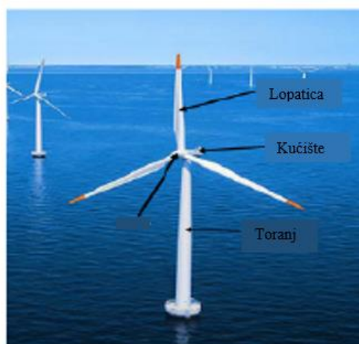
Slika 14. Hibridni sustav vjetroturbina [16]
