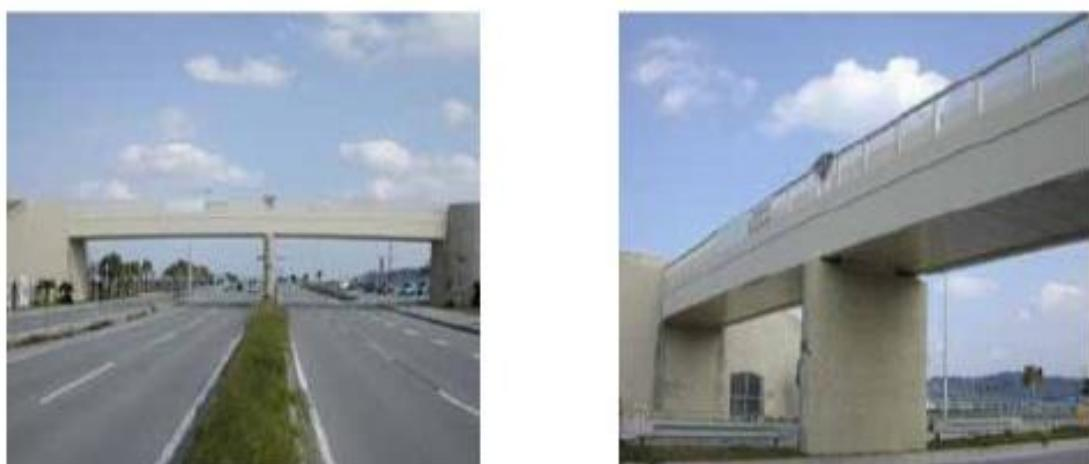
**Slika 15. Pješački most u Okinawi (Japan) napravljen od hibridnog kompozitnog materijala [16]**
