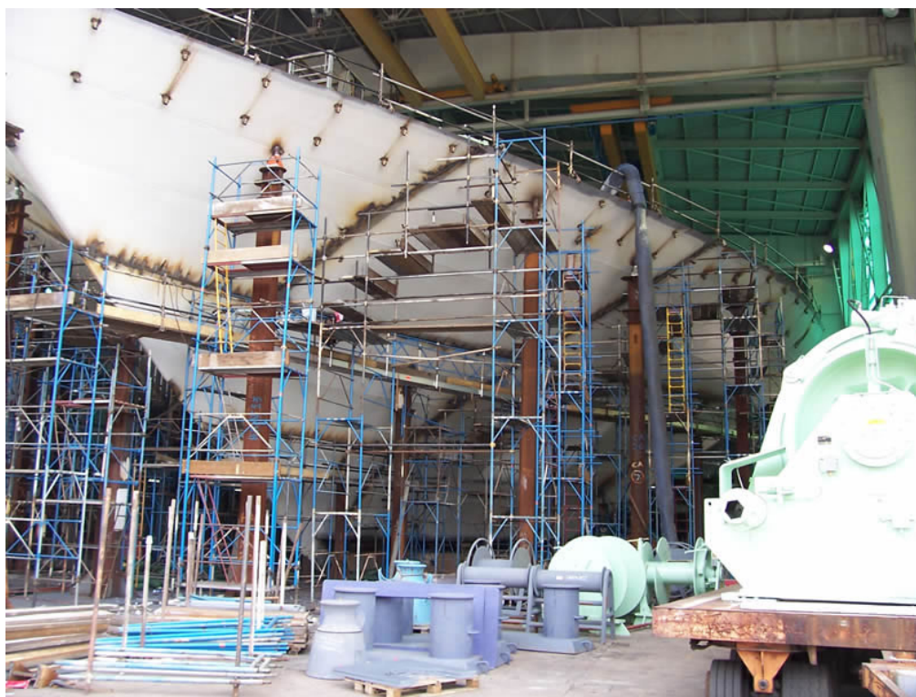
Slika 31 Opremanje sekcije pramca broda za kružna putovanja u brodogradilištu "Fincantieri Monfalcone"
