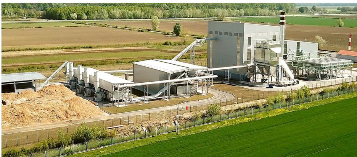
Slika 20. Termoelektrana na biomasu Županja [16]
