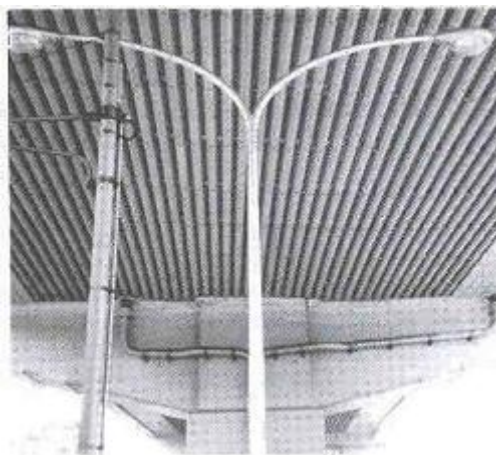
Slika 4.8. Vijadukt čija je donja površina izvedena od metalne pjene [1]
