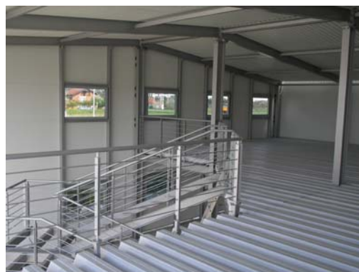
Slika 7. Sekundarna krovna konstrukcija. Slika 8. Paneli oslonjeni na IPE i cijevne profile.
