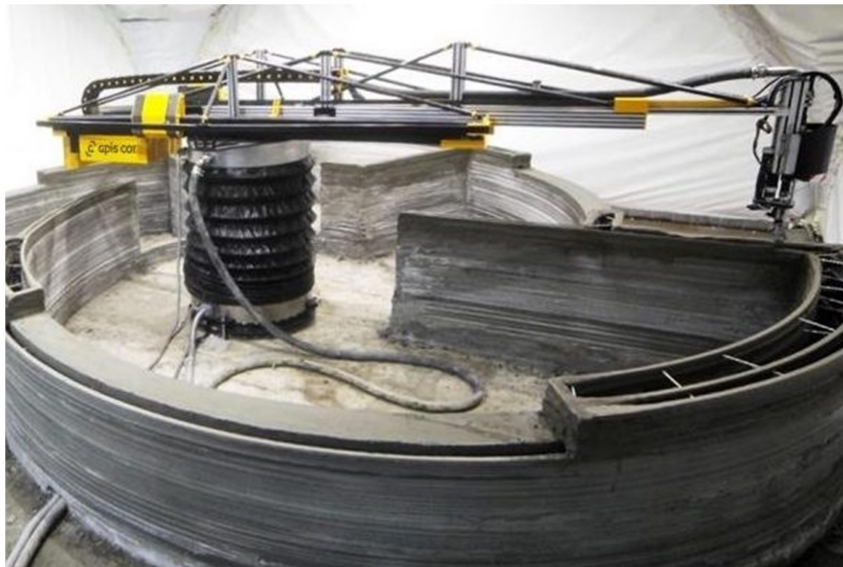
Slika 6 Polarna izvedba 3D printera za građevine [8]
