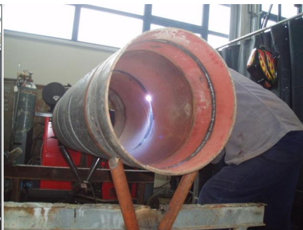
Slika 7.6 b) Zavarivanje STT postupkom- 3 sata
