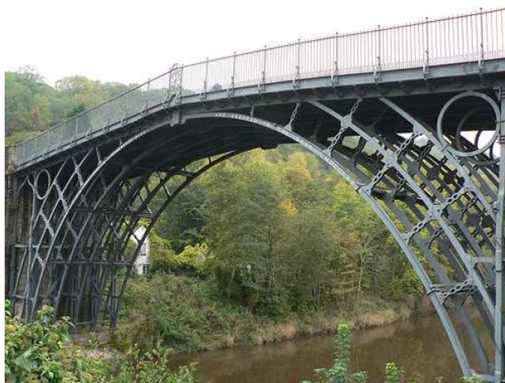
Slika 1. Prvi most izrađen od željeznog lijeva [1]
