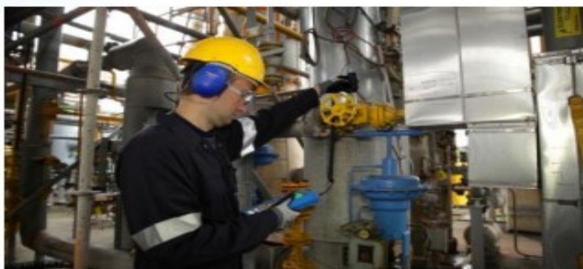
Slika 11. Inspekcija ventila bezkontaktnim senzorom [2]
