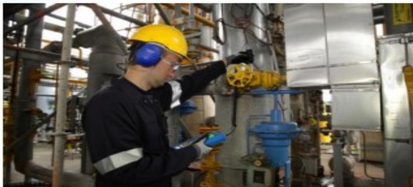
**Slika 11. Inspekcija ventila bezkontaktnim senzorom [2]**
