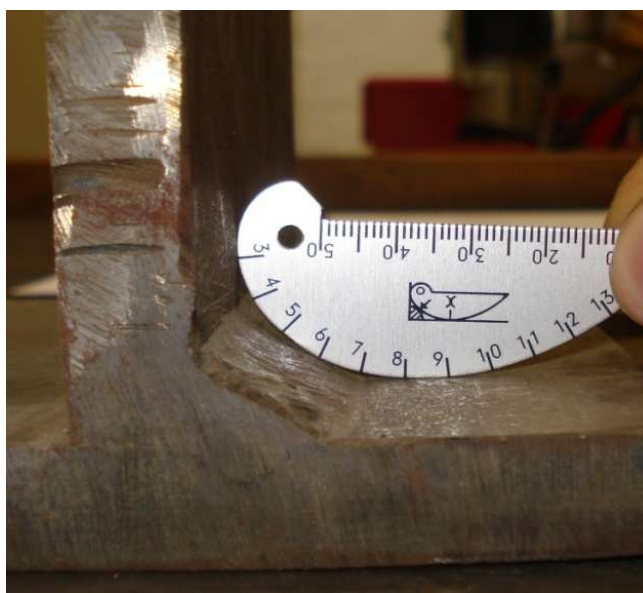
Slika 5. Mjerenje debljine kutnog zavarenog spoja jednostavnim mjerilom za zavarene spojeve
