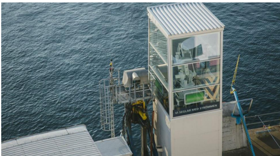
Slika 2 Punjač ForSea električnog broda [2]
