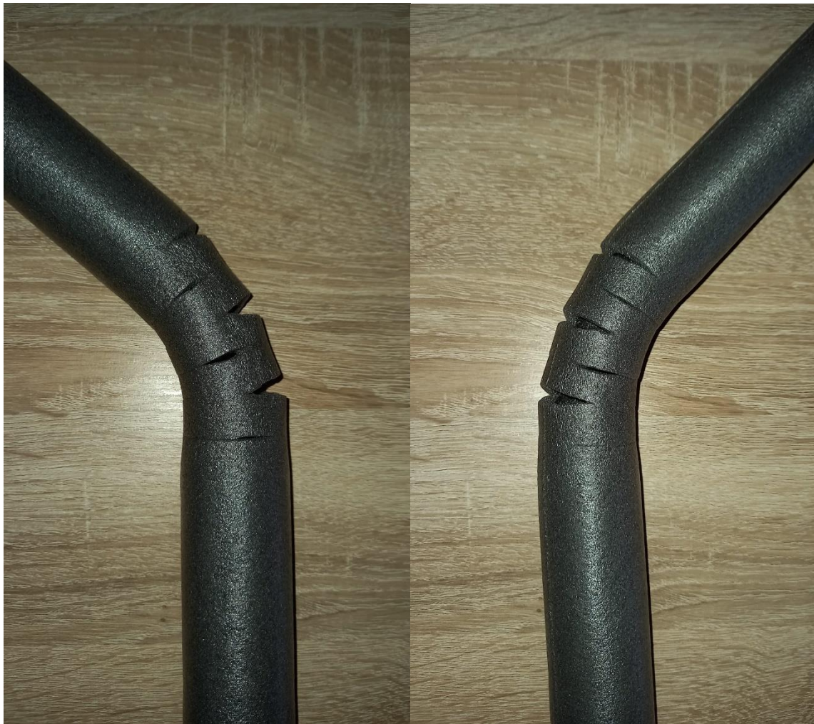
Slika 29. Savijanje nosača
