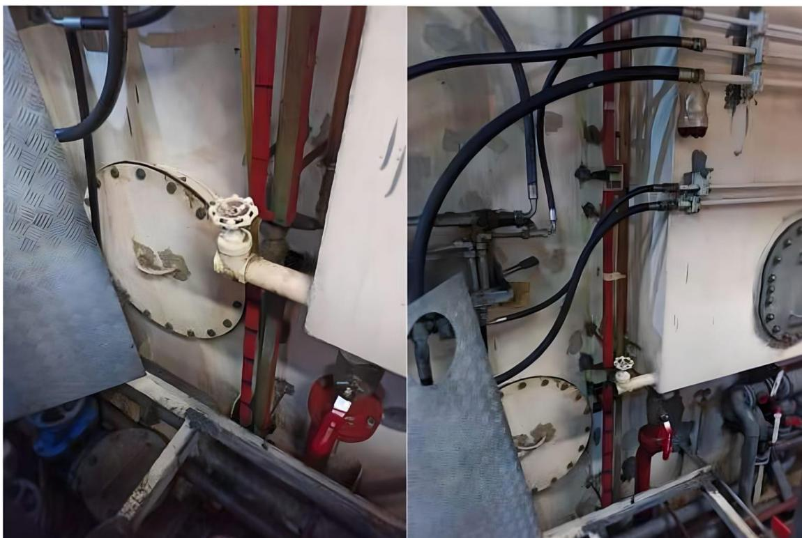
Slika 10. Ugrađeno mjerilo stanja spremnika na plivaričaru "Noa"
