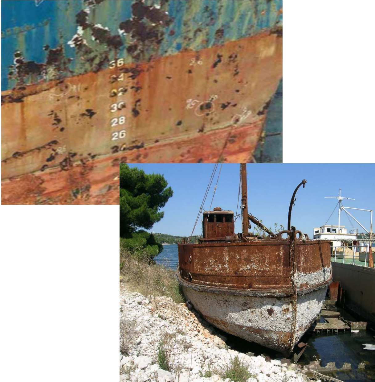
Slika 1. Razaranje zaštitne prevlake i korozija broskog trupa [3]
