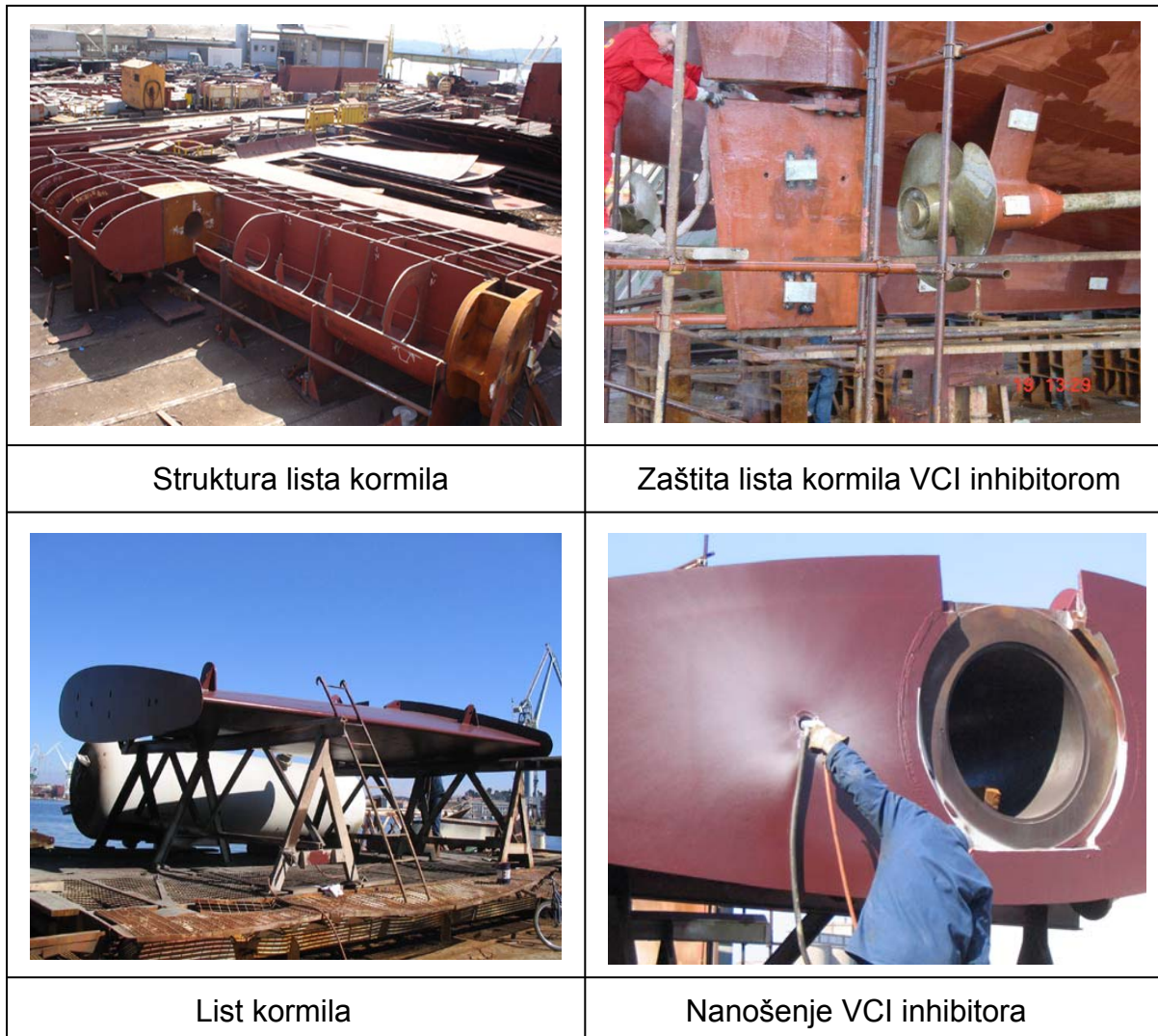
Slika 28. Zaštita lista kormila hlapljivim inhibitorima korozije [3]
