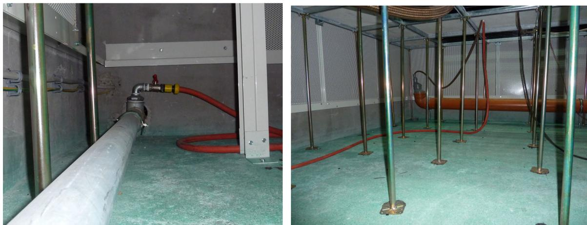
*Slika 5.3 . Vodovodni priključak i kanalizacijski odvod u prostoru ispod poda laboratorija*
