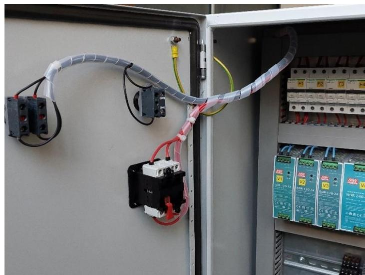
Slika 15. Zaštita ožičenja do sklopke i tipkala na vratima upravljačkog ormara
