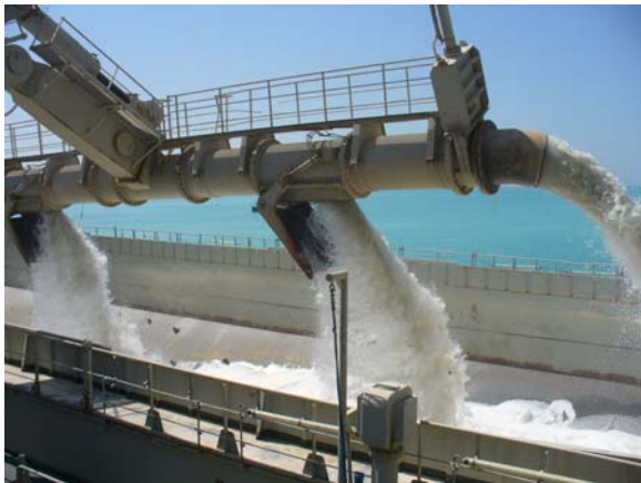
Slika 8. : Iskrcaj iskapanog tereta na baržu
