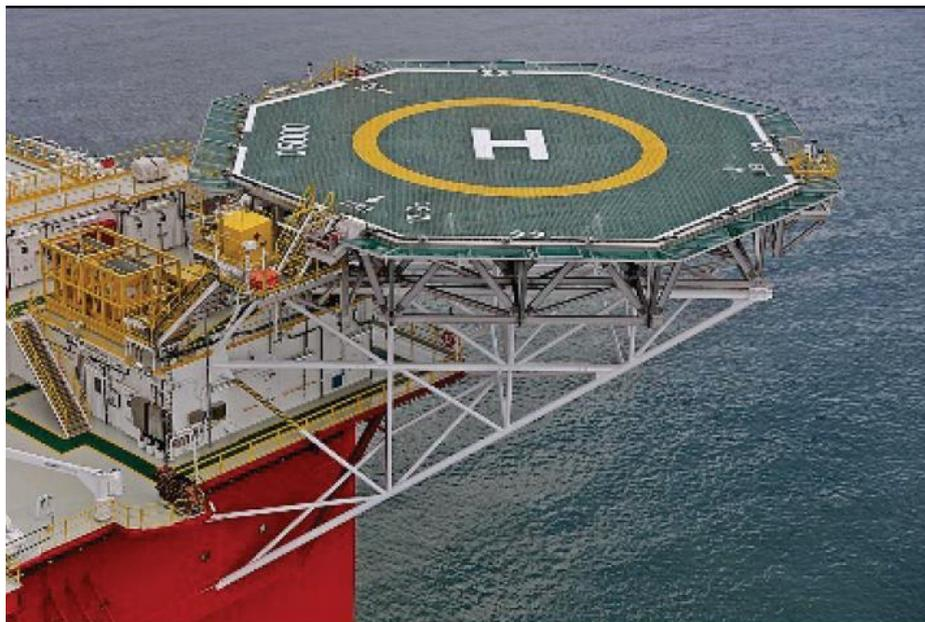
**Slika 2. Primjer primjene Al-legura u građevinarstvu – konstrukcija heliodroma na platformi [4]**
