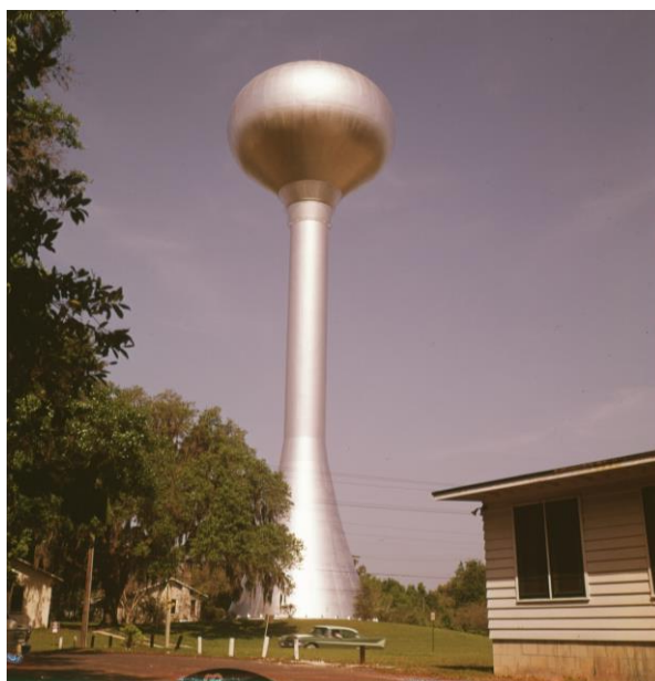
Slika 29. Primjer samostojećeg stupa s konusnim dnom
