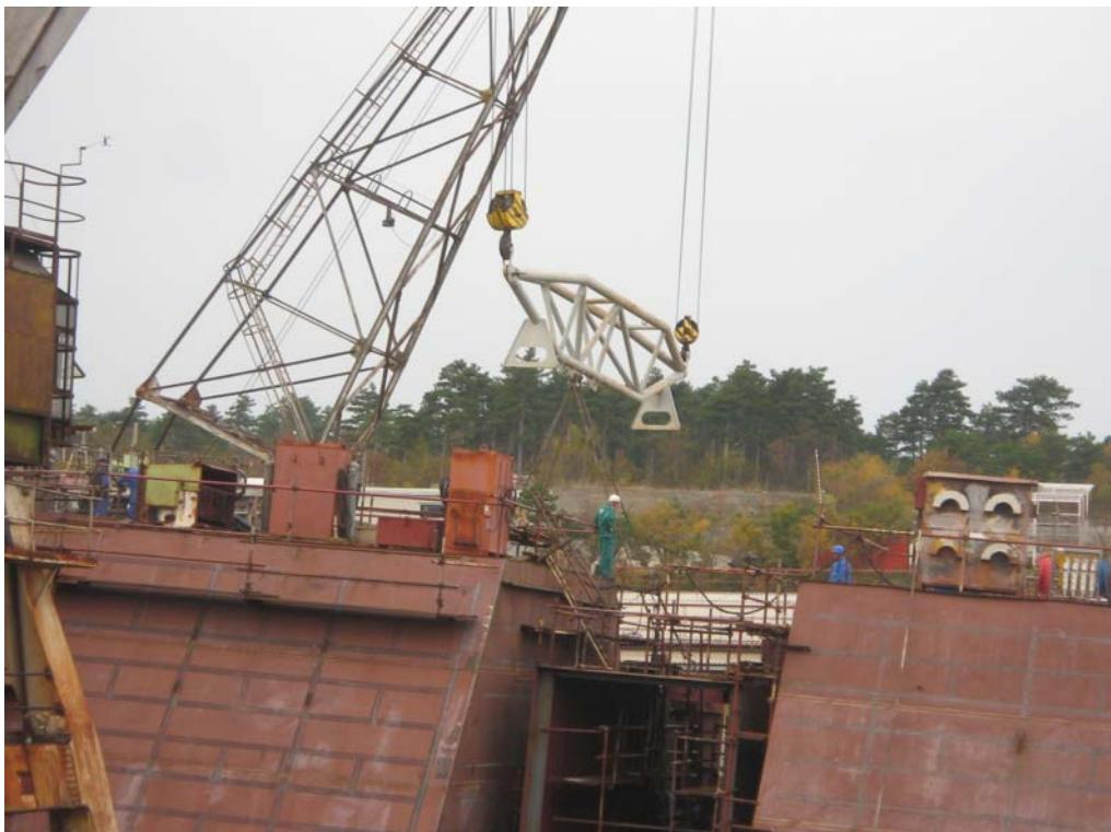
**Slika 31 Rešetkasti nosač za prihvati i manipulaciju sekcija kod rada dizalica u tandemu**
