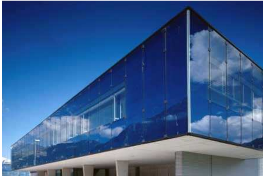
Slika 1. Pilkington - Ovještene i ventilirane fasade [1]
