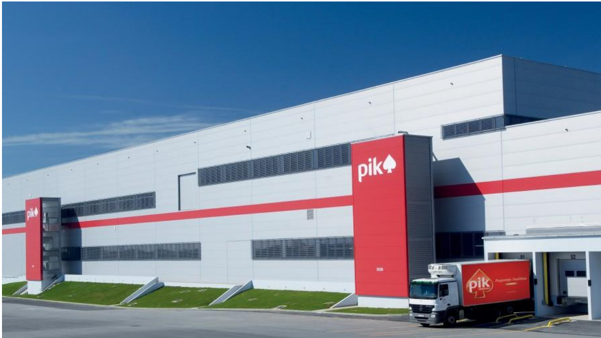
Slika 1 Novi dio tvornice
