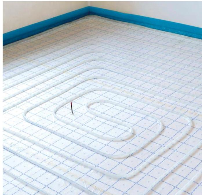
Slika 16. Prikaz montaže cijevi podnog grijanja [13]
