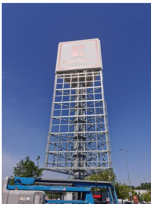
Slika 16. Konstrukcija zaštićena alkidnim premazima
