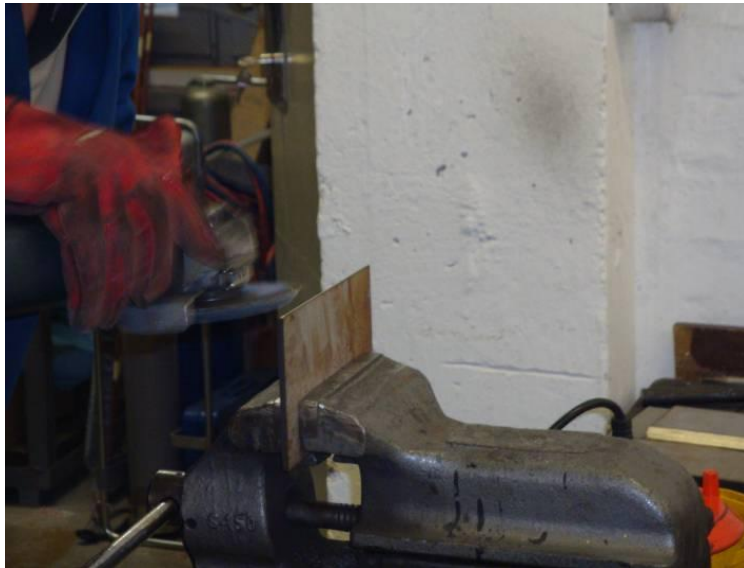
Slika 16. Priprema žlijeba za zavarivanje.
