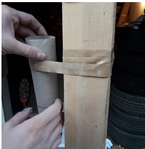
Slika 100. Treći način - namatanje papira na predložak
