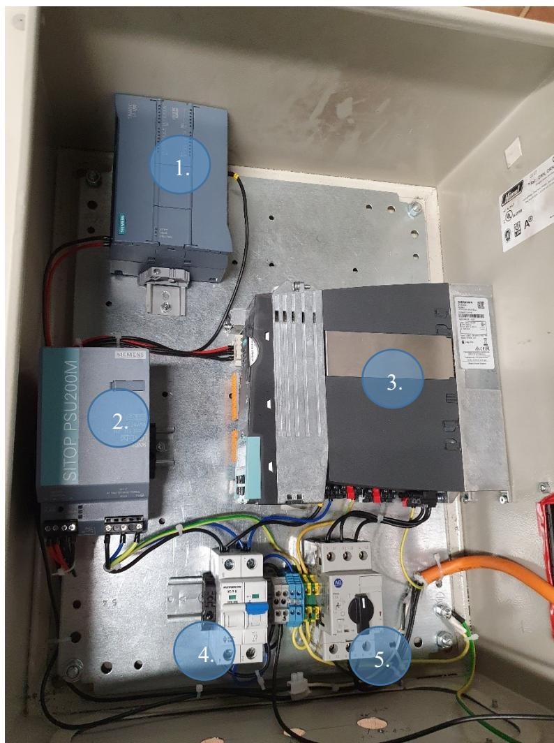
Slika 24. Sklop električnih komponenti. 1. PLC, 2. SITOP 24V istosmjerno napajanje, 3. frekvencijski pretvarač Sinamics S120 CU310-2, 4. osigurač napajanja, 5. motorna zaštitna sklopka
