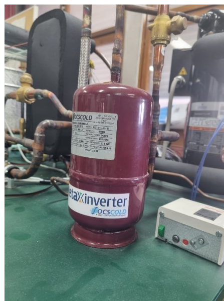
Slika 10. Odvajač ulja
