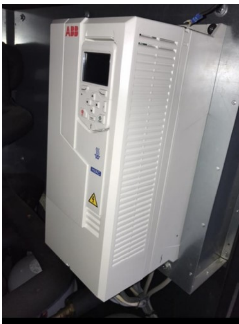
Slika 17. Frekvencijski pretvarač ABB ACH580-01 [2]
