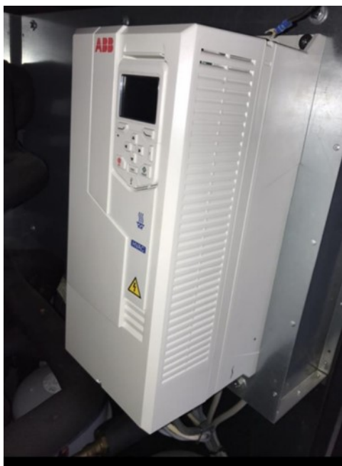
Slika 17. Frekvencijski pretvarač ABB ACH580-01 [2]
