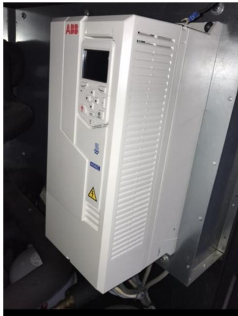
Slika 17. Frekvencijski pretvarač ABB ACH580-01 [2]
