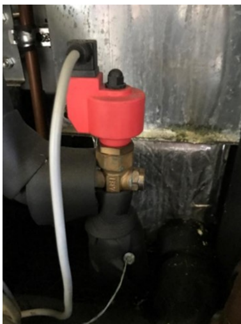
Slika 8. Elektronički ekspanzijski ventil Carel E2V24 [2]
