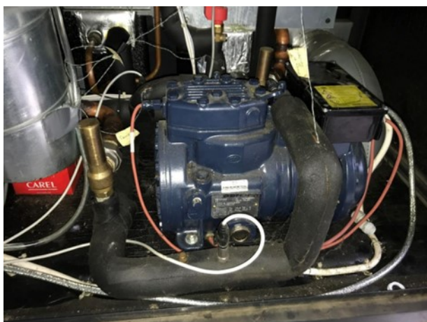
Slika 6. Poluhermetički stapni kompresor Dorin [2]
