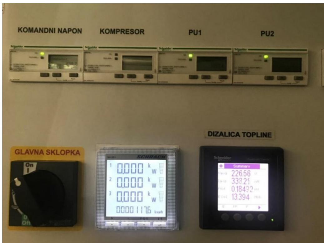
Slika 9. Multimetri proizvođača Schneider i Schrack [2]
