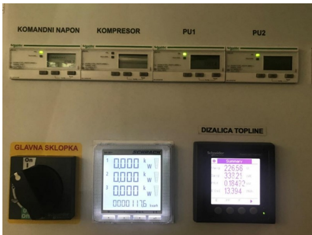
Slika 9. Multimetre proizvođača Schneider i Schrack [2]
