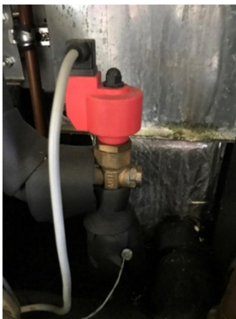
Slika 8. Elektronički ekspanzijski ventil Carel E2V24 [2]
