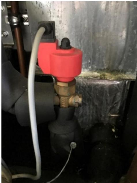
Slika 8. Elektronički ekspanzijski ventil Carel E2V24 [2]
