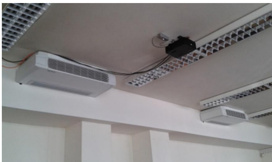
Slika 4. Ventilokonvektori Sabiana [3]
