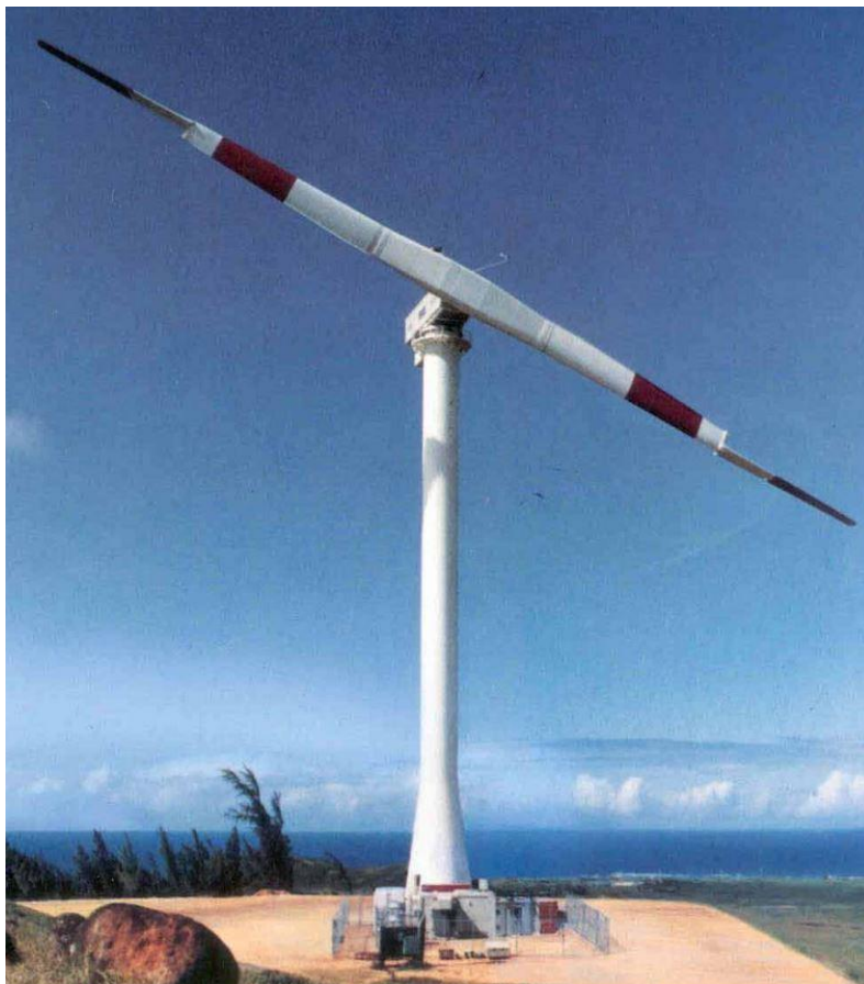
Slika 20. Vjetroturbina MOD- 5B (3,2 MW) [27]
