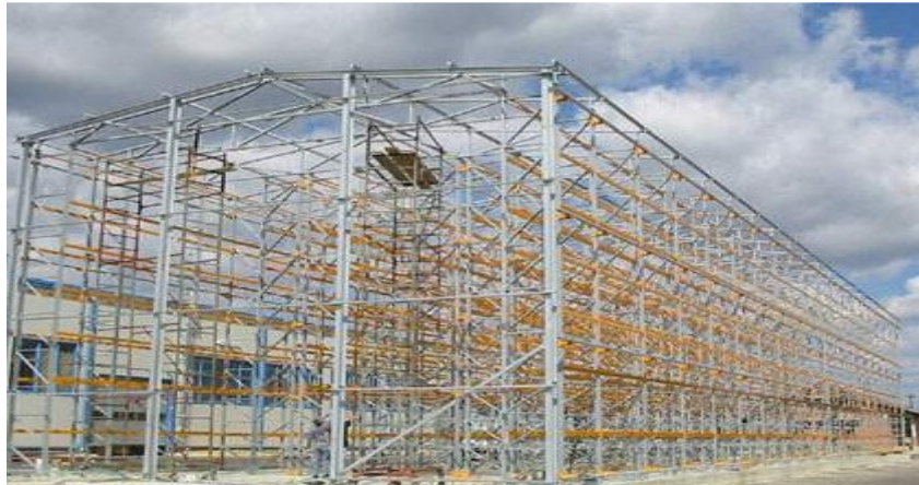
Slika 23. Samonosivo regalno skladište
