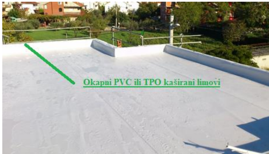
Slika 1. Primjer ravnog krova izvedenog PVC hidroizolacijskom membranom
