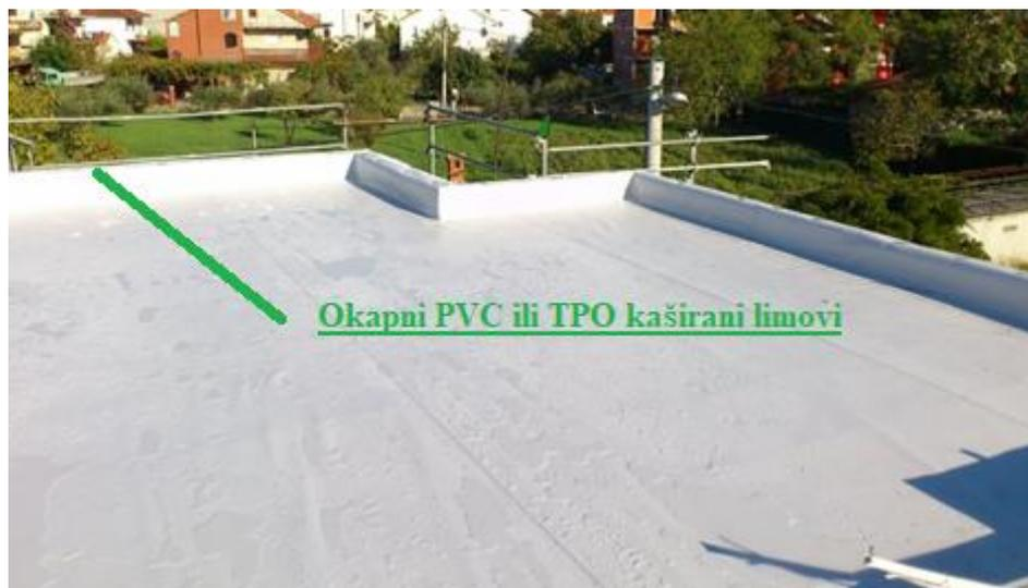
**Slika 1. Primjer ravnog krova izvedenog PVC hidroizolacijskom membranom**
