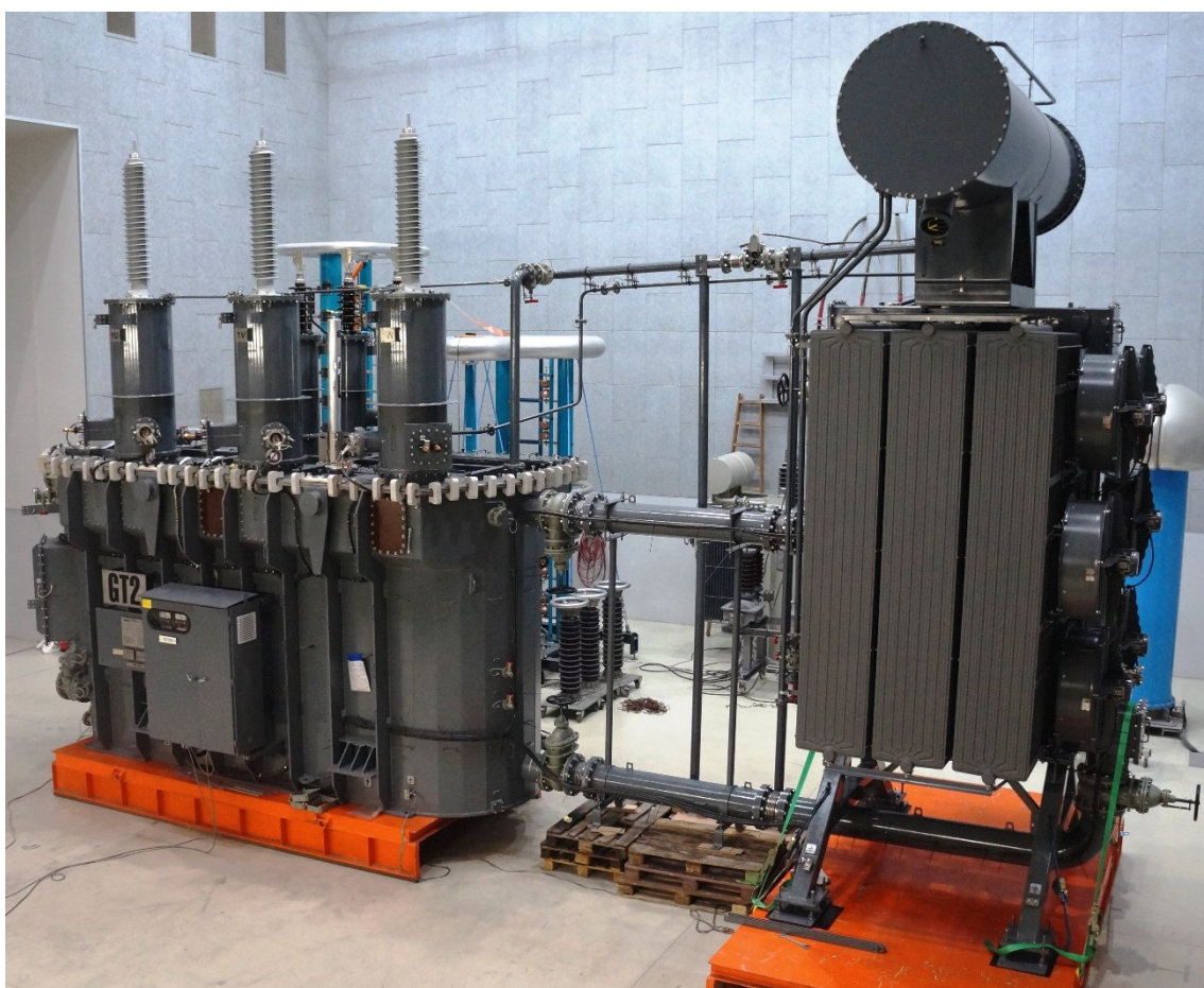
Slika 2.5 Odvojeni sustav za hlađenje transformatora 1 [5]
