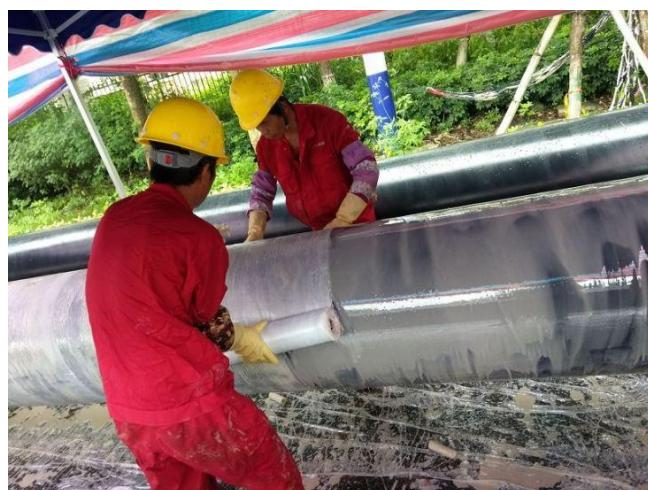
Slika 16. Oblaganje cijevi staklenim vlaknima [26]
