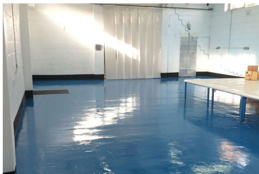
Slika 15. Pod od tekućeg epoksidnog premaza [25]
