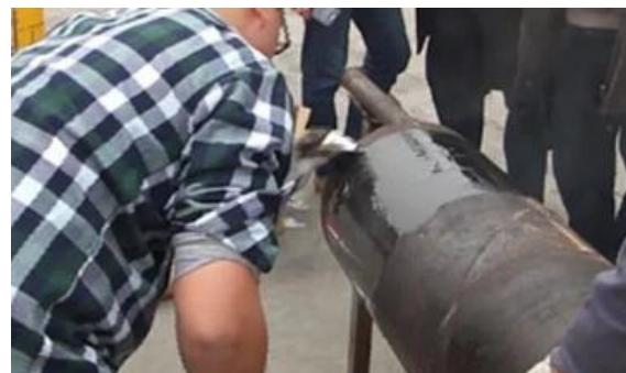
Slika 14. Zaštita cijevi dvokomponentnim epoksidnim premazom [24]
