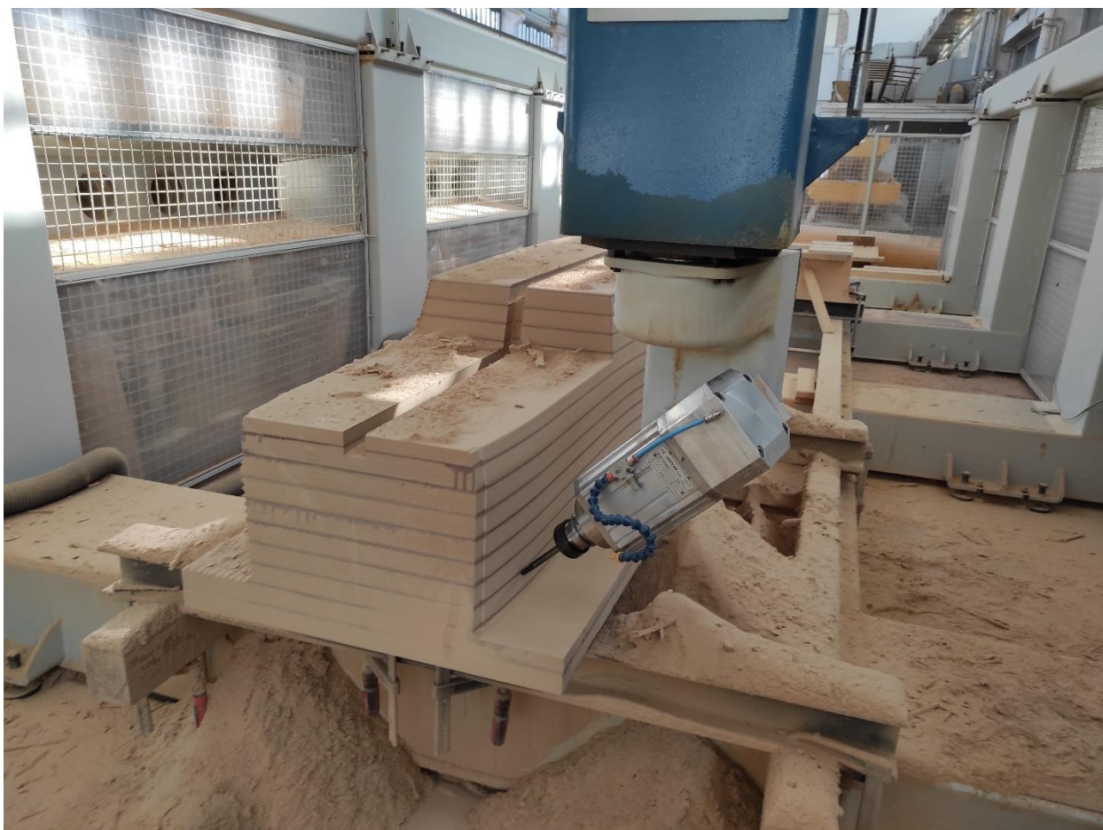
Slika 6.18. Fina obrada kalupa na petrosnom obradnom centru
