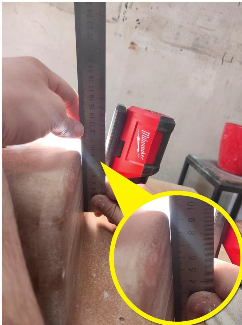
Slika 6.28. Provjera ravnosti površina: primjer neravne površine
