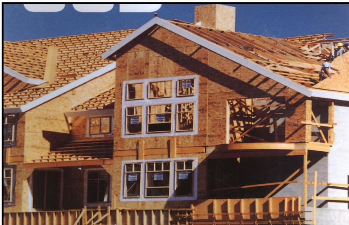
Slika 3.4. Lijepljene ploče s usmjerenim iverjem kao obloga i vertikalna oplata okvirne konstrukcije drvenih kuća [8]
