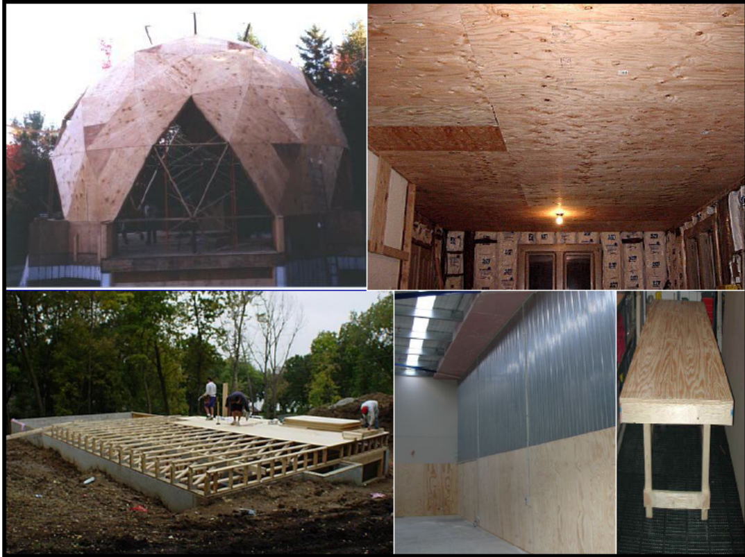
Slika 3.2. Primjena furnirskih ploča u graditeljstvu [8]
