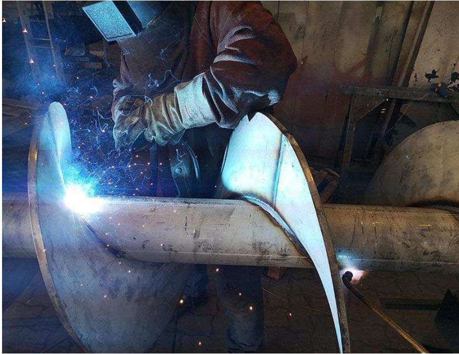
Slika 15. Zavarivanje segmenata velike pužnice na osovini [8]
