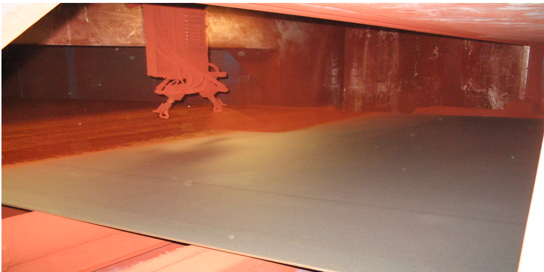
Slika 60. Lim zaštićen "shopprimerom", Brodogradilište Uljanik, Pula
