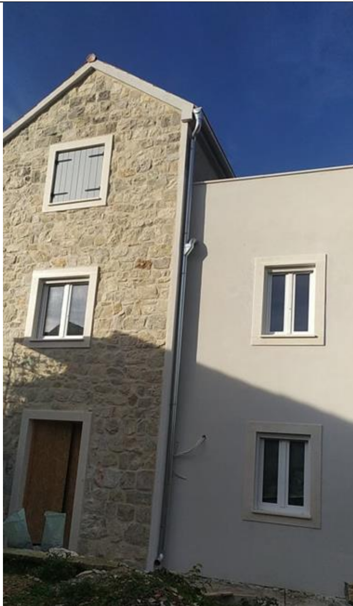
Slika 6. istočna fasada kuće
