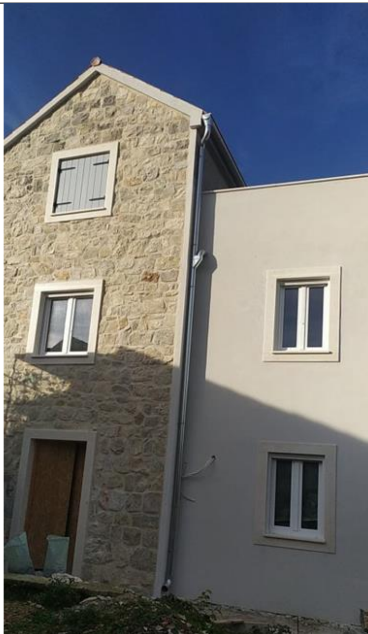
Slika 6. istočna fasada kuće
