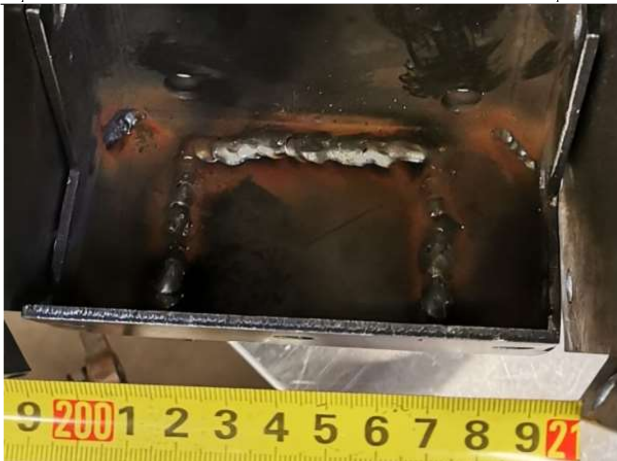
Slika 27 Zavareni spoj izveden u proizvodnom pogonu TEP-a
