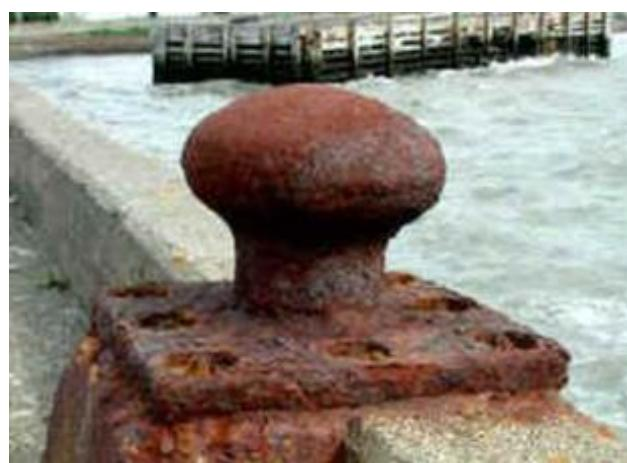
Slika 14. Opća korozija stupu za vez broda [22]
