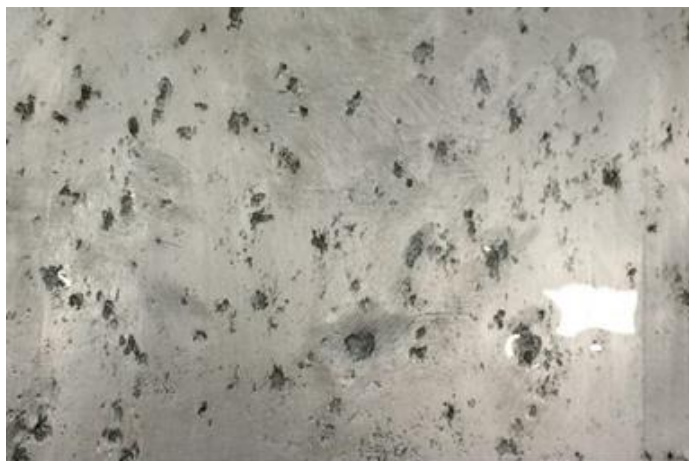
Slika 15. Rupičasta korozija aluminija [24]
