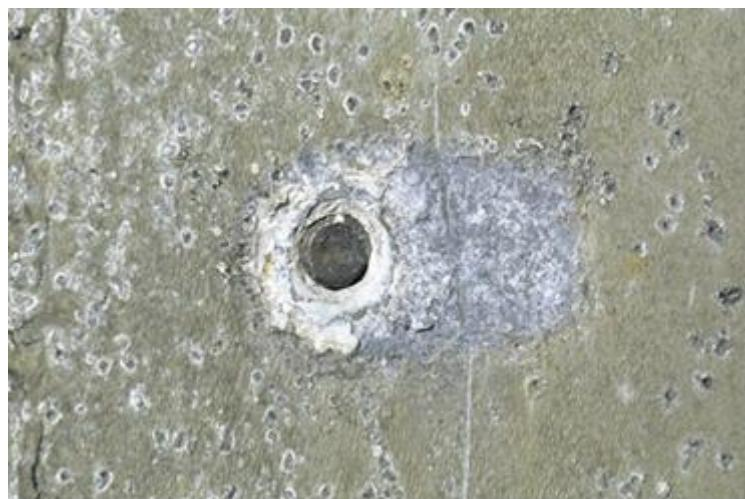
Slika 18. Galvanska korozija aluminija i čelika [24]
