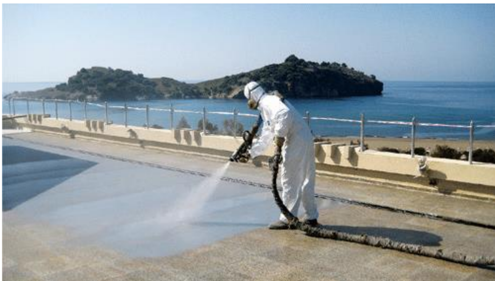
Slika 13. Nanošenje poliuree na betonski most. [28]
