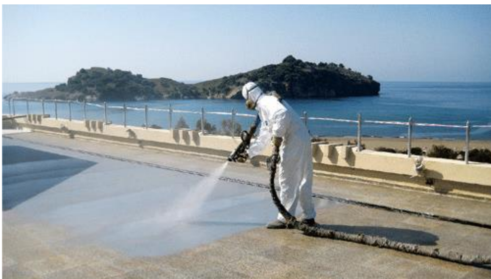
Slika 13. Nanošenje poliuree na betonski most. [28]
