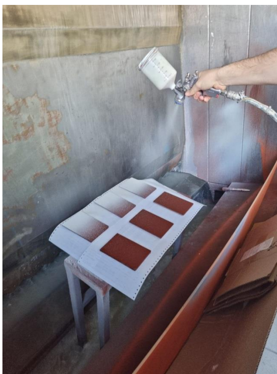
Slika 21. Nanošenje završnog sloja.
