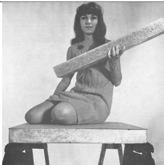
Slika 11. Bjorkstenova demonstracija male težine i krutosti metalnih pjena 1960.-tih godina [1]
