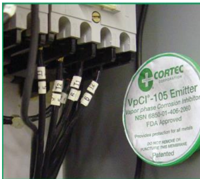
Slika 8. Zaštita osiguračke kutije korištenjem inhibitora [16]
