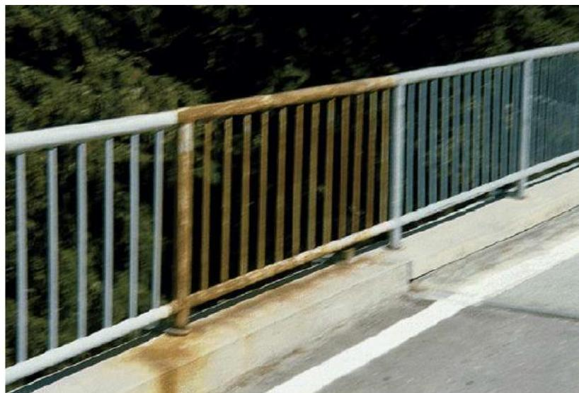
Slika 1. Opća korozija [5]
