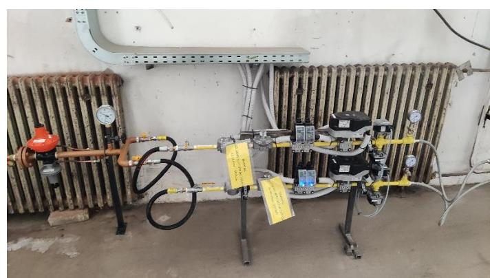
**Slika 20. Sustav za dovod plina u tvrtki Končar – Metalne konstrukcije**
