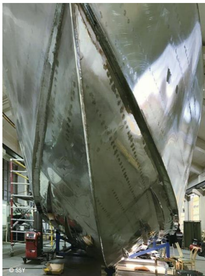
Slika 10. Trup broda od dupleks nehrđajućeg čelika prije poliranja podvodnog dijela i bojanja gornjeg dijela [15]
