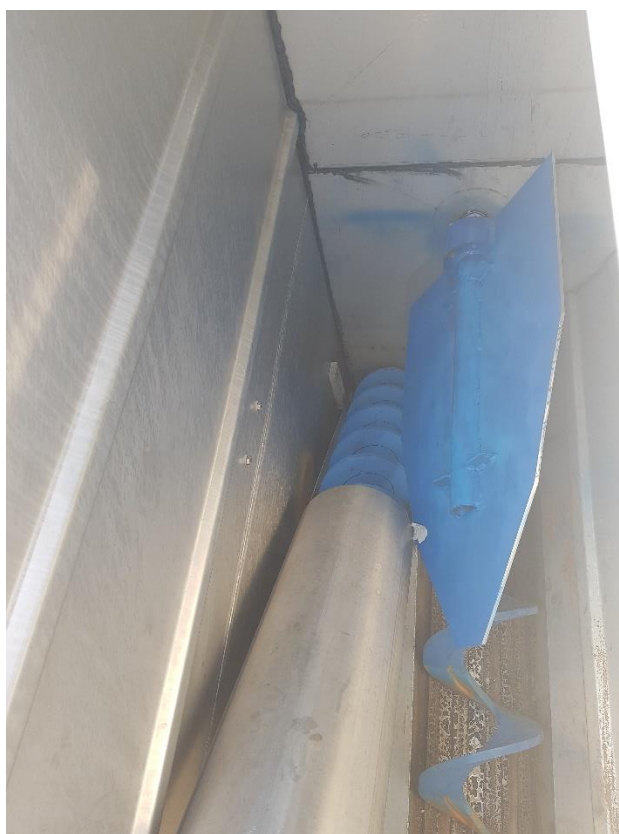
Slika 21. Filter teške frakcije (pjeskolov) [29]
