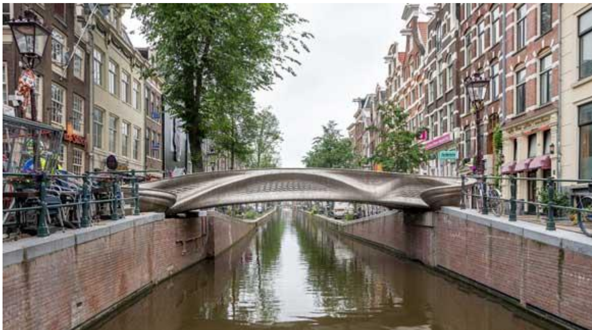
Slika 22. Most od nehrđajućeg čelika proizveden WAAM postupkom [27]
