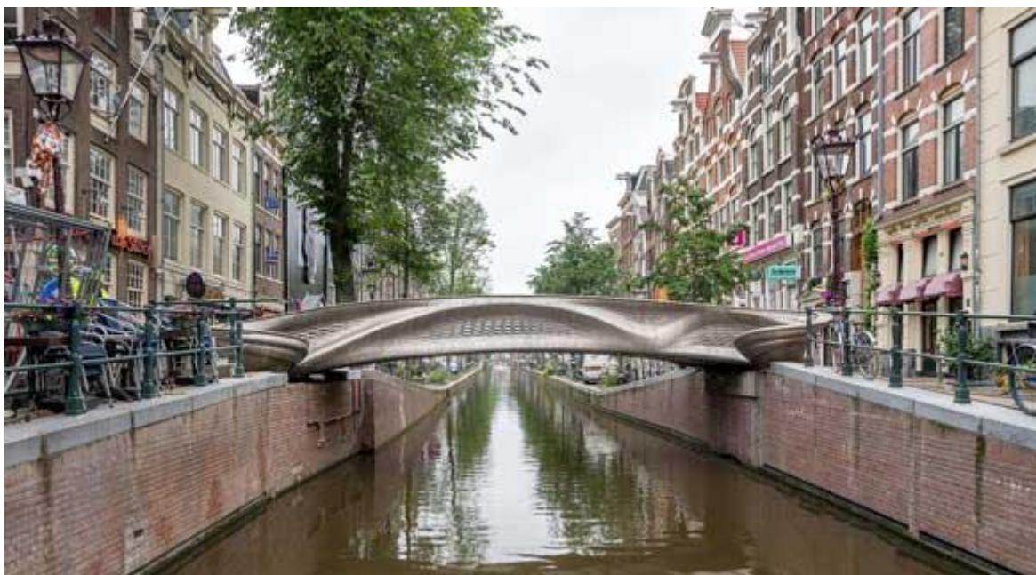
Slika 22. Most od nehrđajućeg čelika proizведен WAAM postupkom [27]
