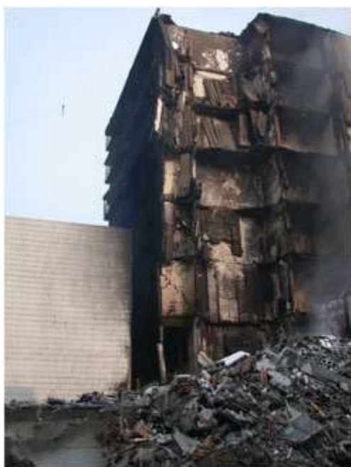
(a) Sjeverno pročelje
