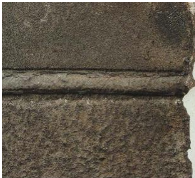
Slika 6. Korozija oblika ureza nožem, iznad zavara AISI 321, ispod zavara AISI 318, temperatura 110°C do 115°C [13]
